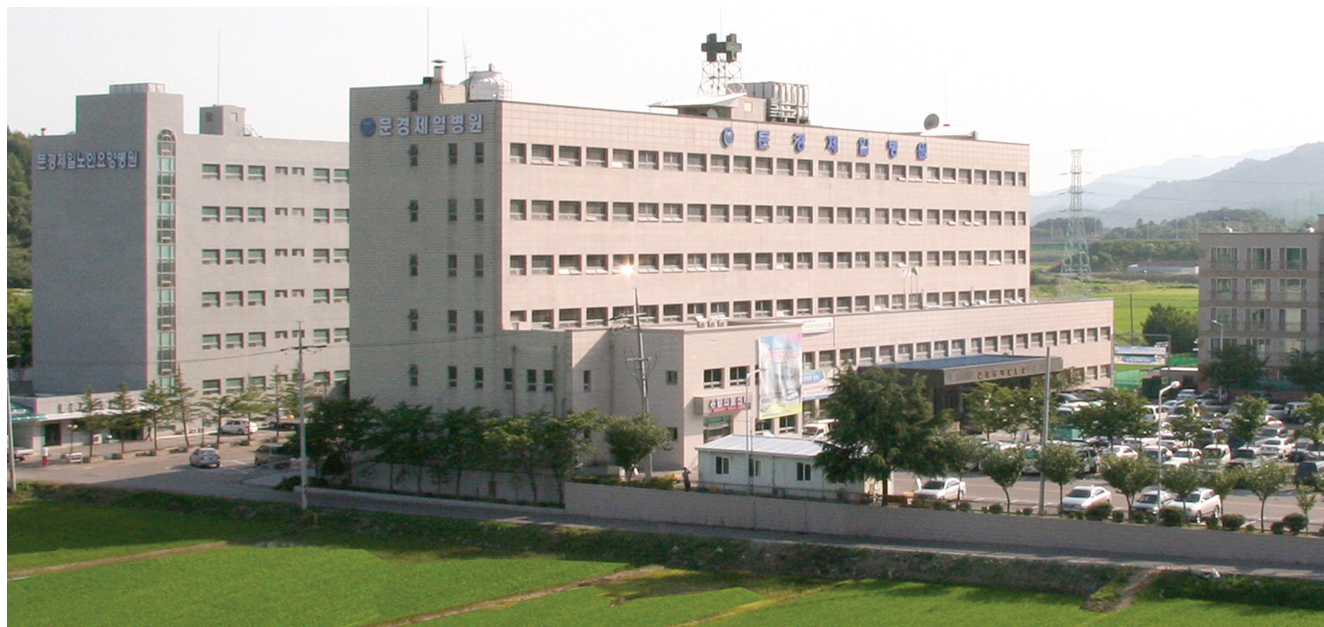
경상북도 문경시 당교3길 25에 위치한 동춘의료재단 문경제일병원 전경.
